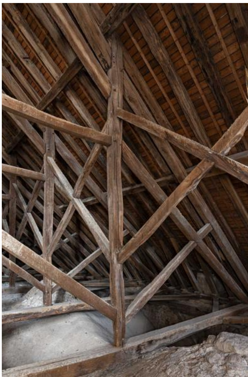
Vue d'une section latérale de la charpente.
