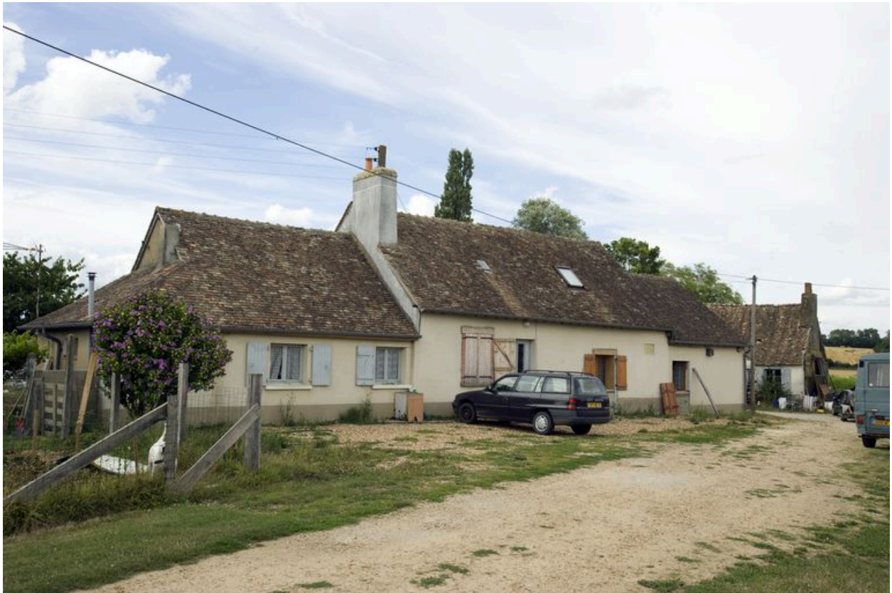
Maison 1, vue générale depuis le sud-est.
