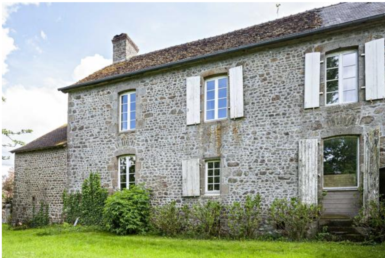
Presbytère, façade nord.
