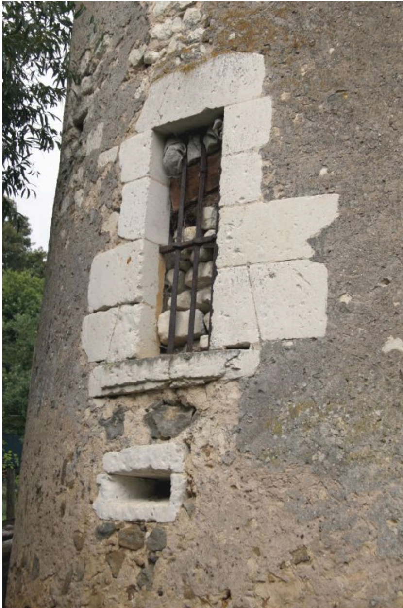
Tourelle, travée de baies : rez-de-chaussée.
