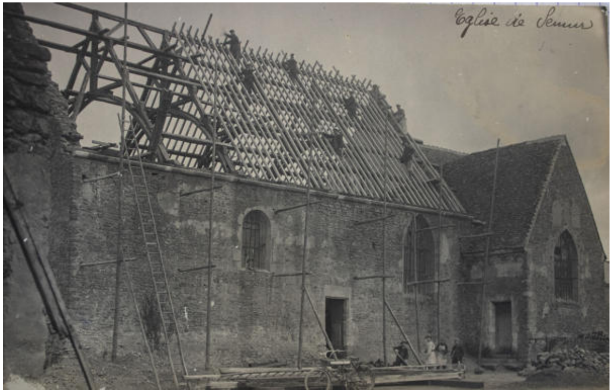
La toiture de l'église en reconstruction, photographie de 1920.
