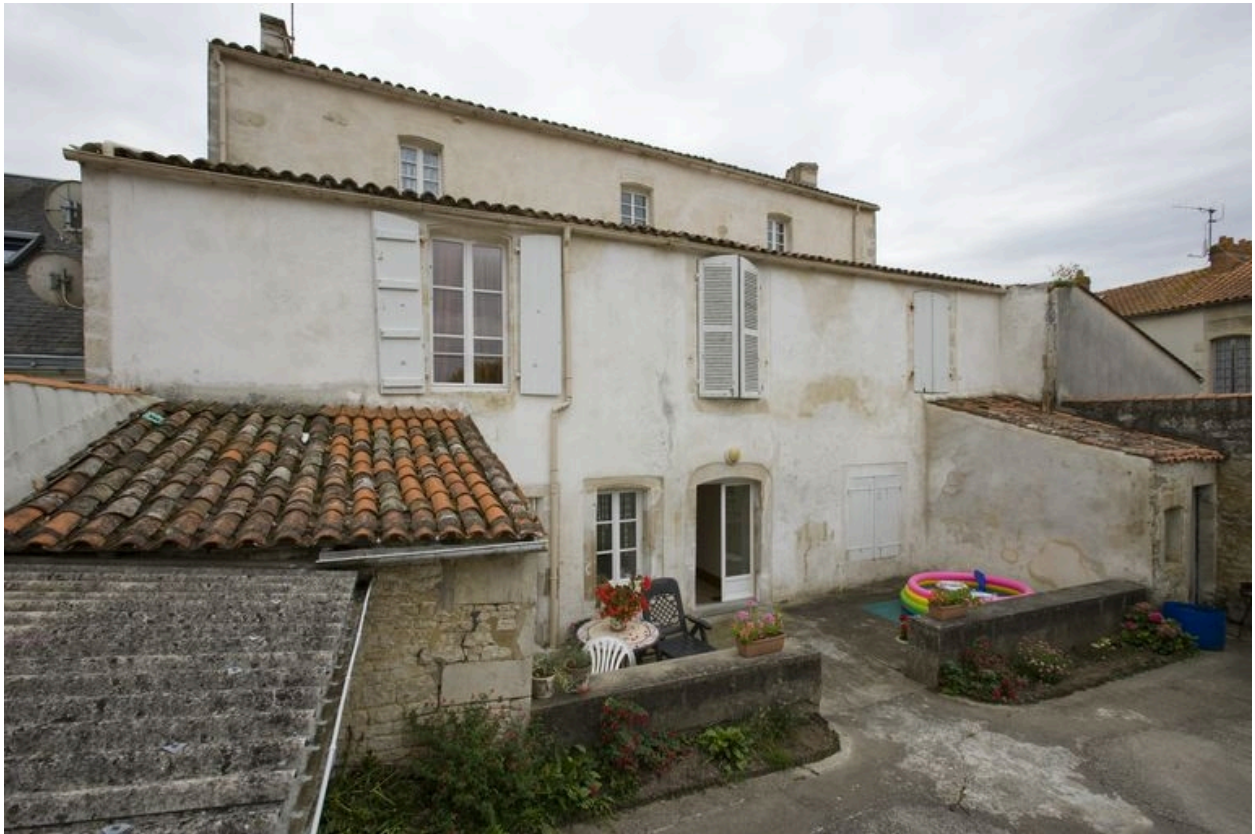
Vue de l'arrière de la maison, prise du nord-ouest.
