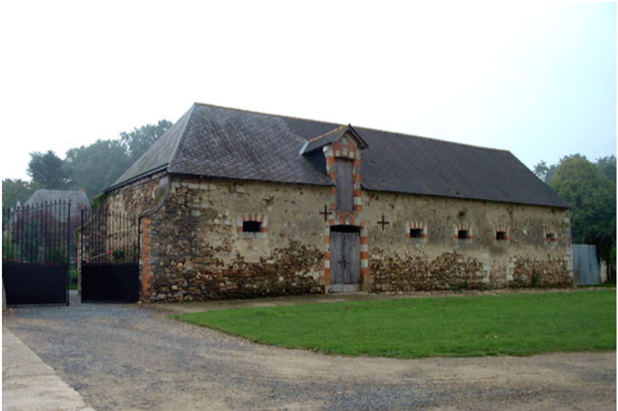
Bâtiment agricole sur le côté occidental de la cour, au sud de l'entrée.
