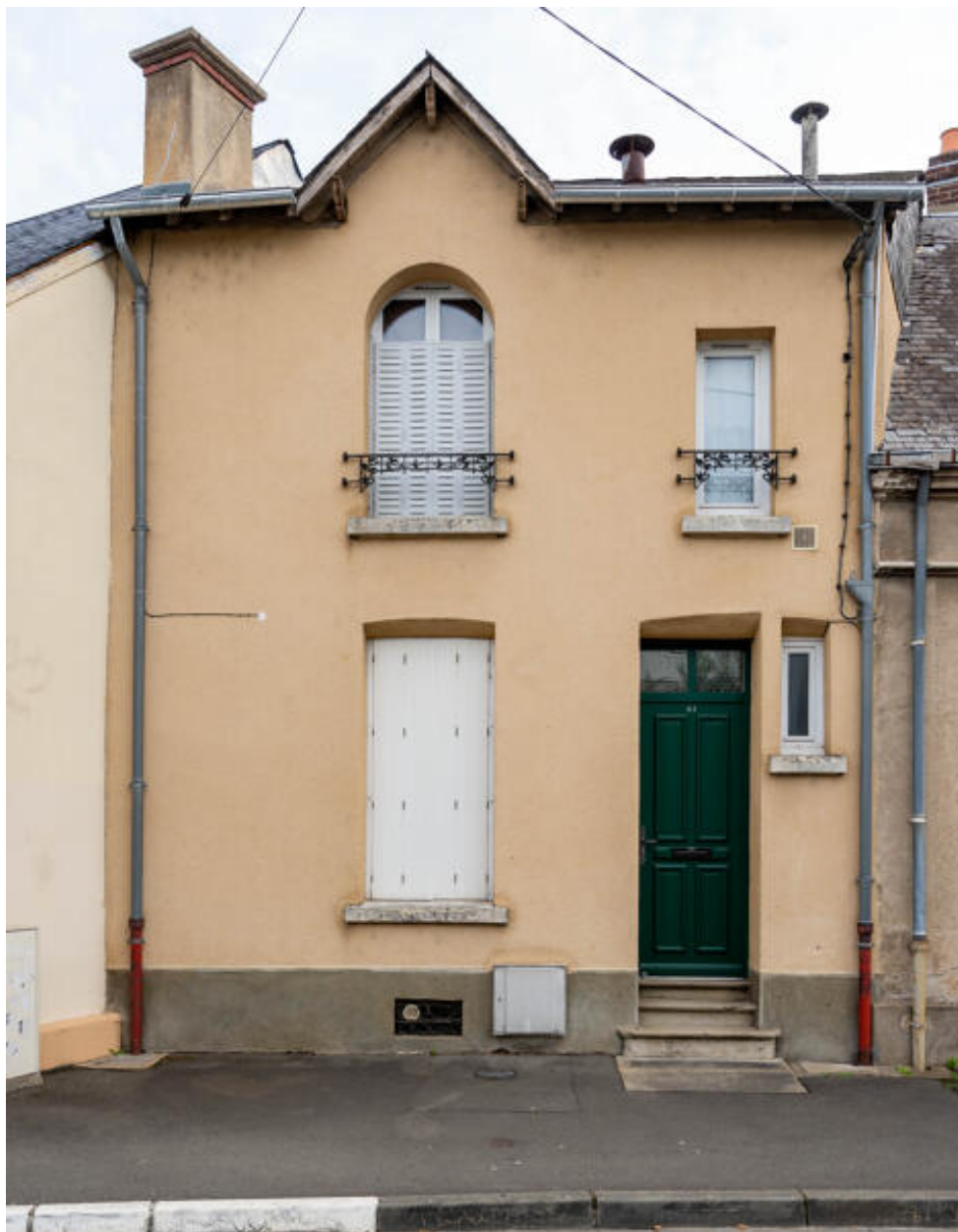
Vue d'une maison exhaussée d'un étage rue du Ponceau.
