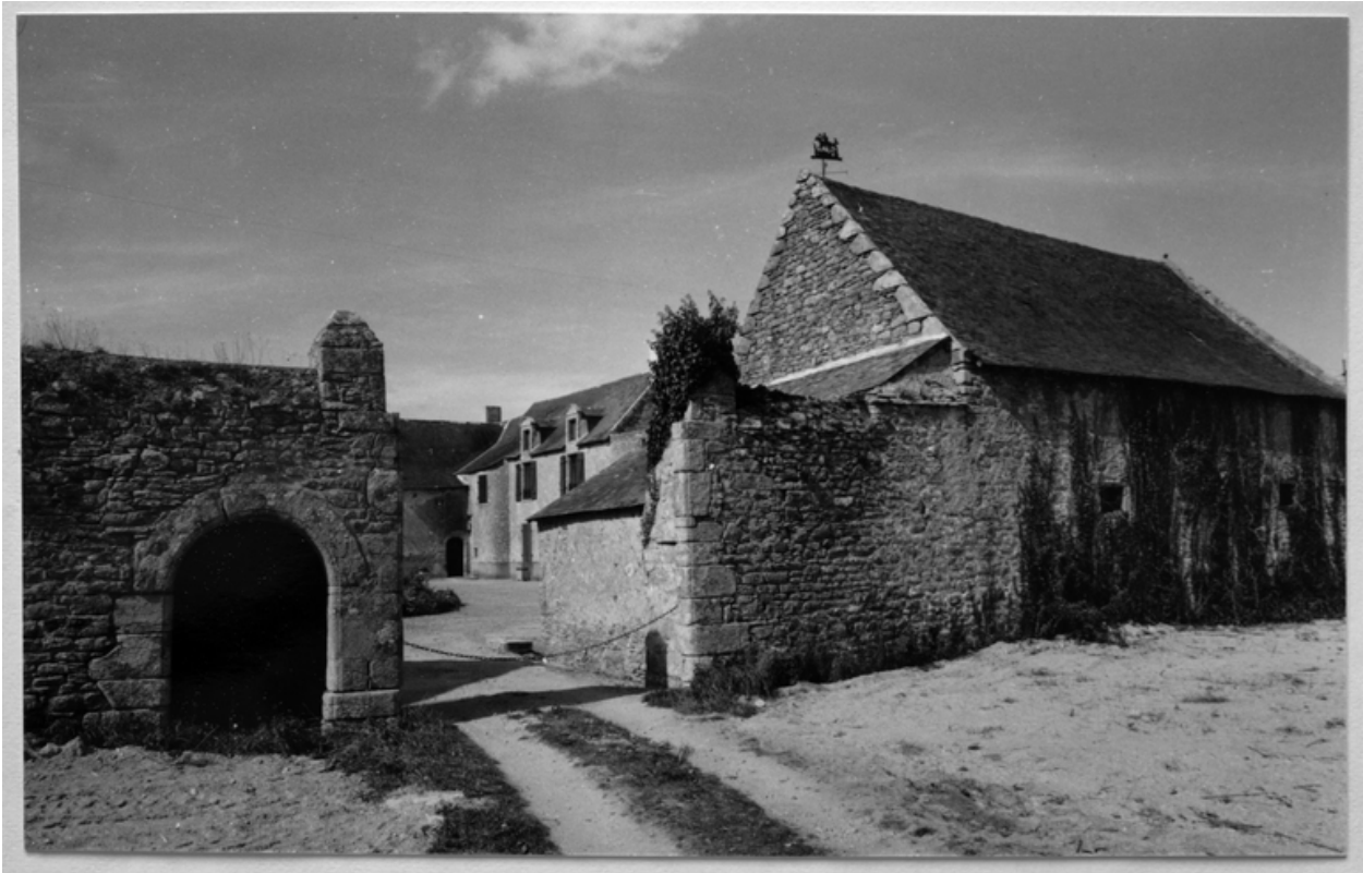
Vue du portail d'entrée depuis le sud-est, 1990.
