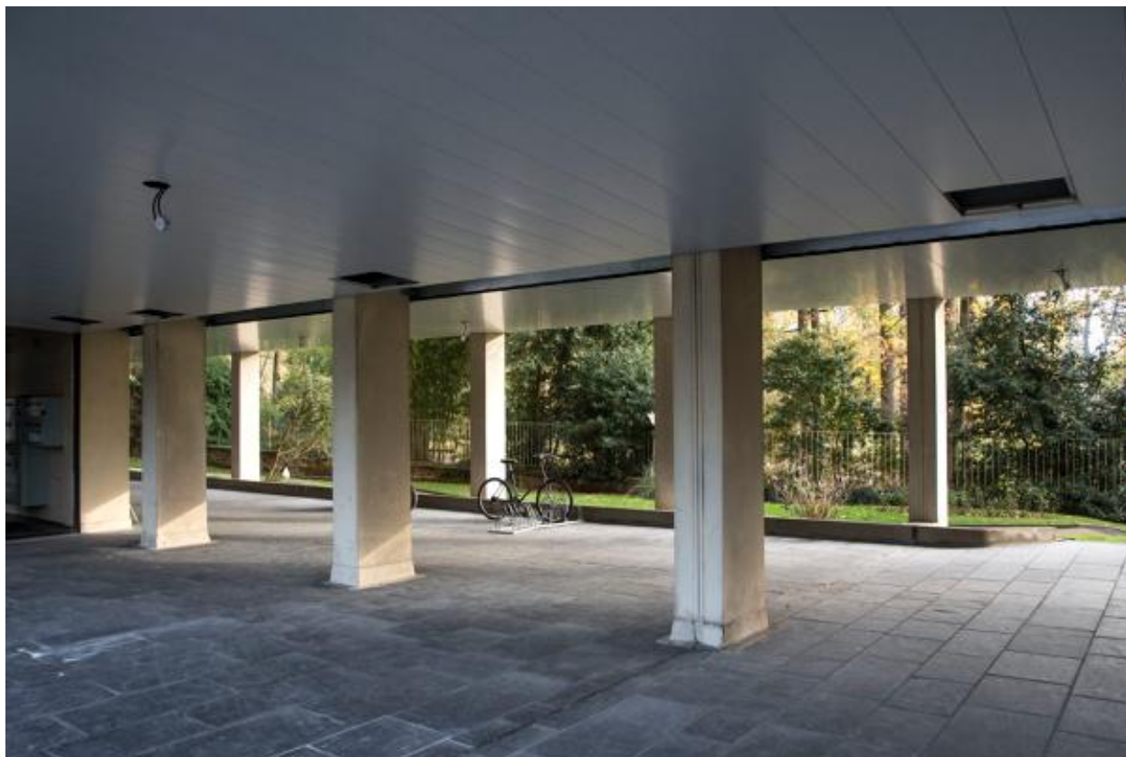
Vue du rez-de-chaussée sur pilotis béton.
