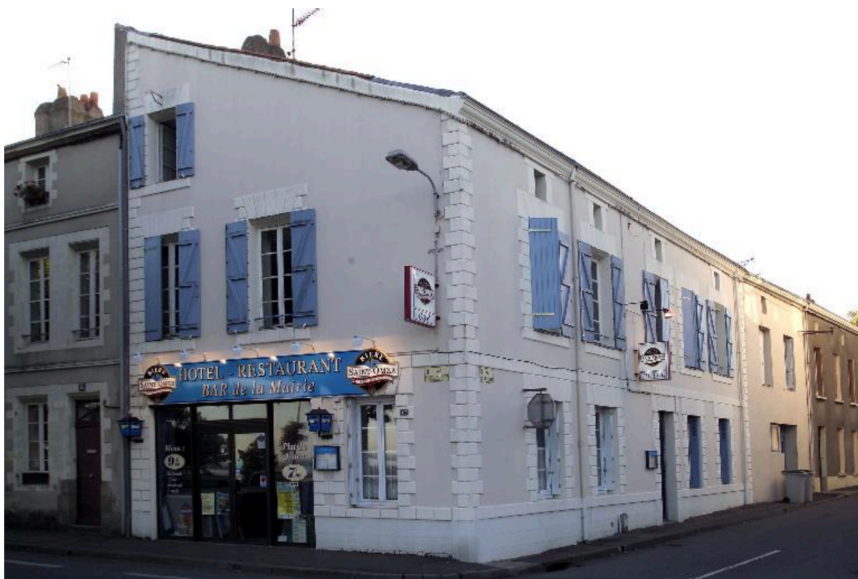
La façade antérieure de la maison n° 17 quai Gautreau.
