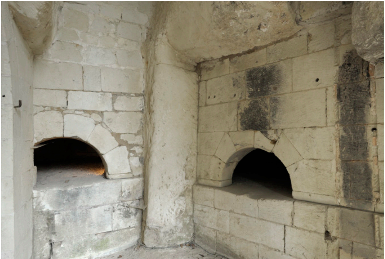
Premier fontis : cavité latérale, avec détail des 2 fours (nord à droite, ouest à gauche).
