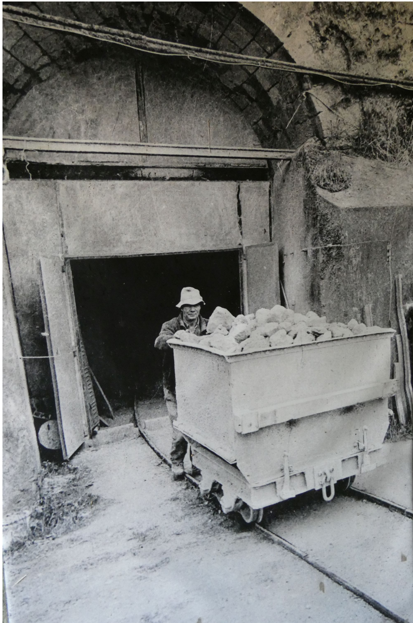
Evacuation de la chaux vive par la trappe de défournement d'un des fours, vers 1960.
