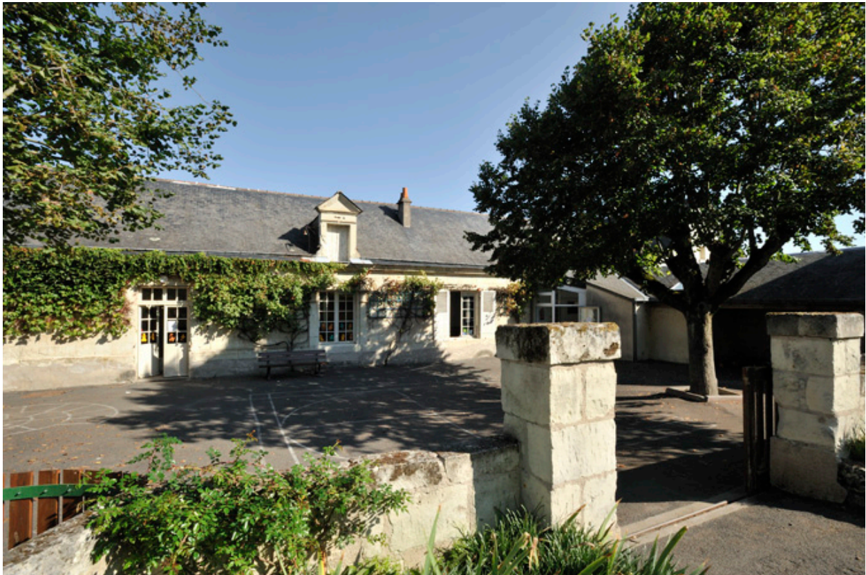
Corps ouest, vue d'ensemble de l'école et de la cour.
