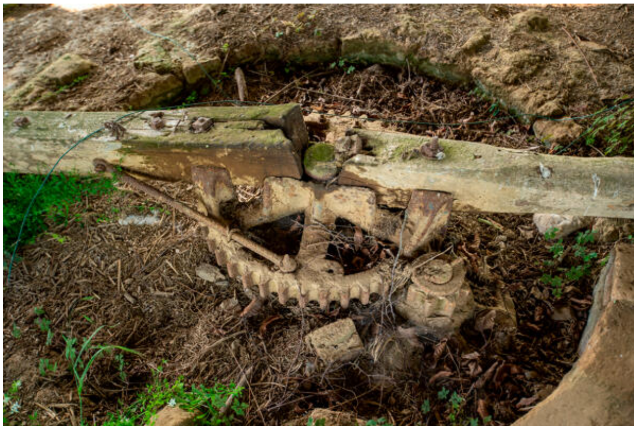
Le manège du puits artésien, détail.
