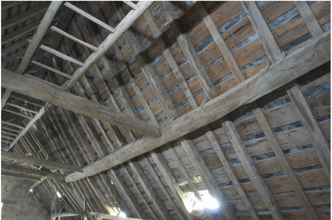
Le pan sud de la charpente de l'ancien logis vu depuis l'ouest.
