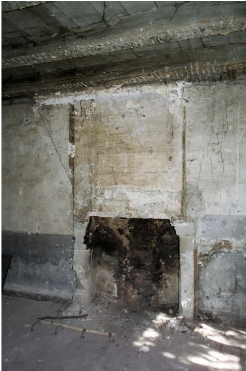
La cheminée de la pièce située du côté de la rue au rez-de-chaussée (2004).
