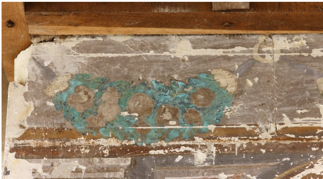
Etage, chambre, mur latéral, cheminée : détail de la guirlande de fleurs repeinte.
