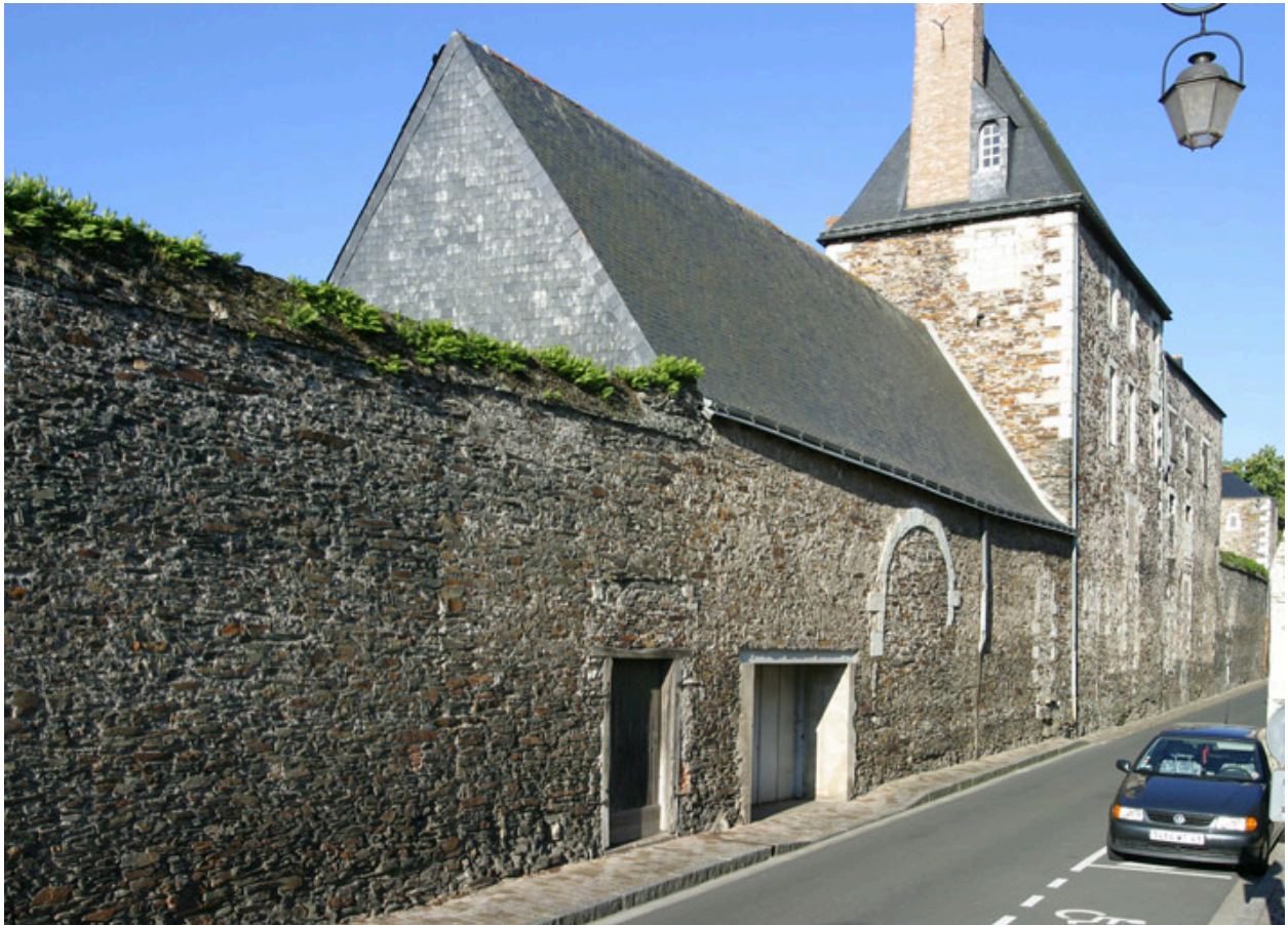
Vue de l'enclos d'est en ouest, rue Monfroux.
