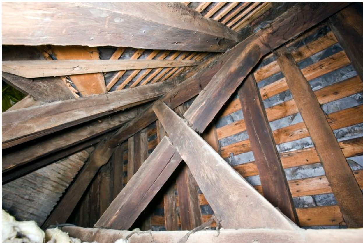
Charpente : chevrons-arbalétriers des fermes, poinçon et contreventement longitudinal en croix de St-André, vue vers le fond de la maison.
