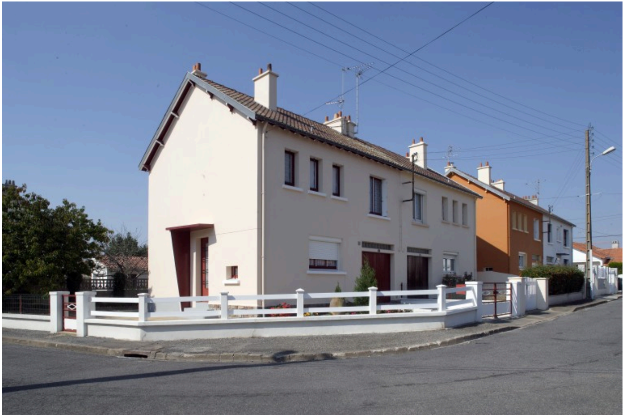
Vue de la rue des Goëlands vers la rue des Amourettes.
