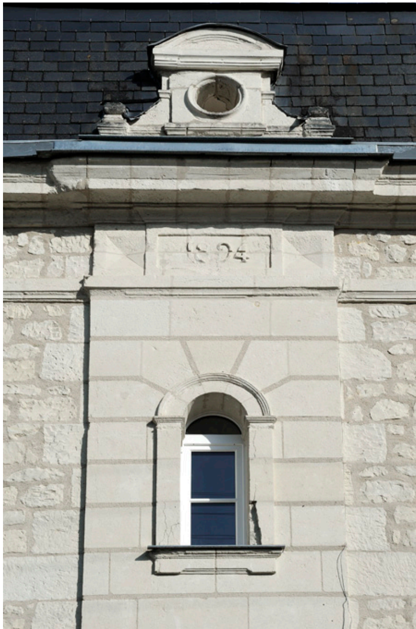
Maison de la directrice : haut de la travée axiale
