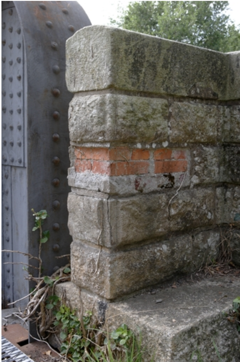
Détail des garde-corps en brique recouvert d'un parement en pierre.
