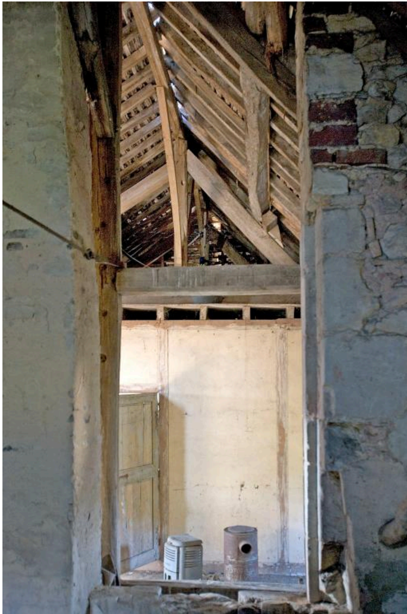
Le pavillon, comble, détail de la charpente, 2007.
