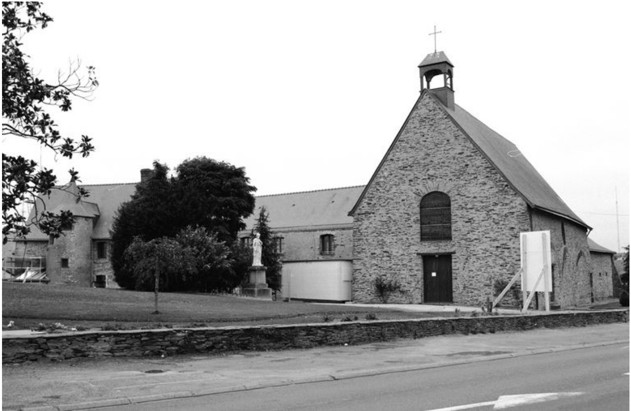
Bâtiment de l'ancienne aumônerie Saint-Jean, vue d'ensemble depuis le nord-est. De gauche à droite, logis, salles des malades, chapelle.
