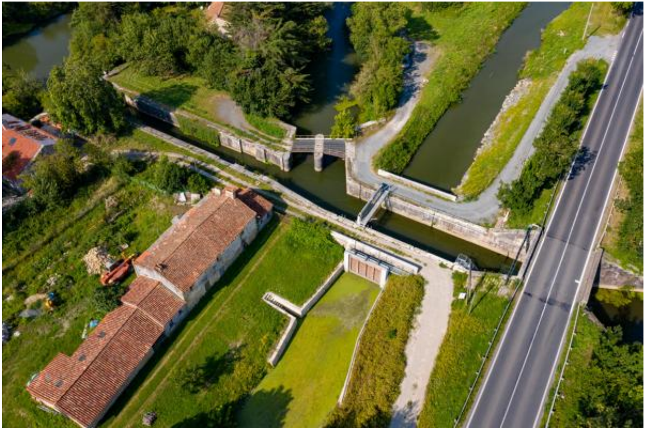
Vue aérienne depuis l'ouest.
