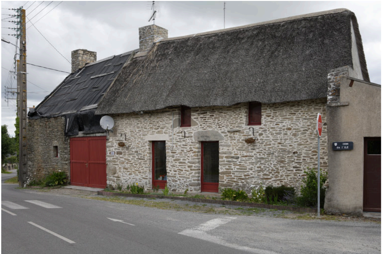
Vue depuis le sud-est.
