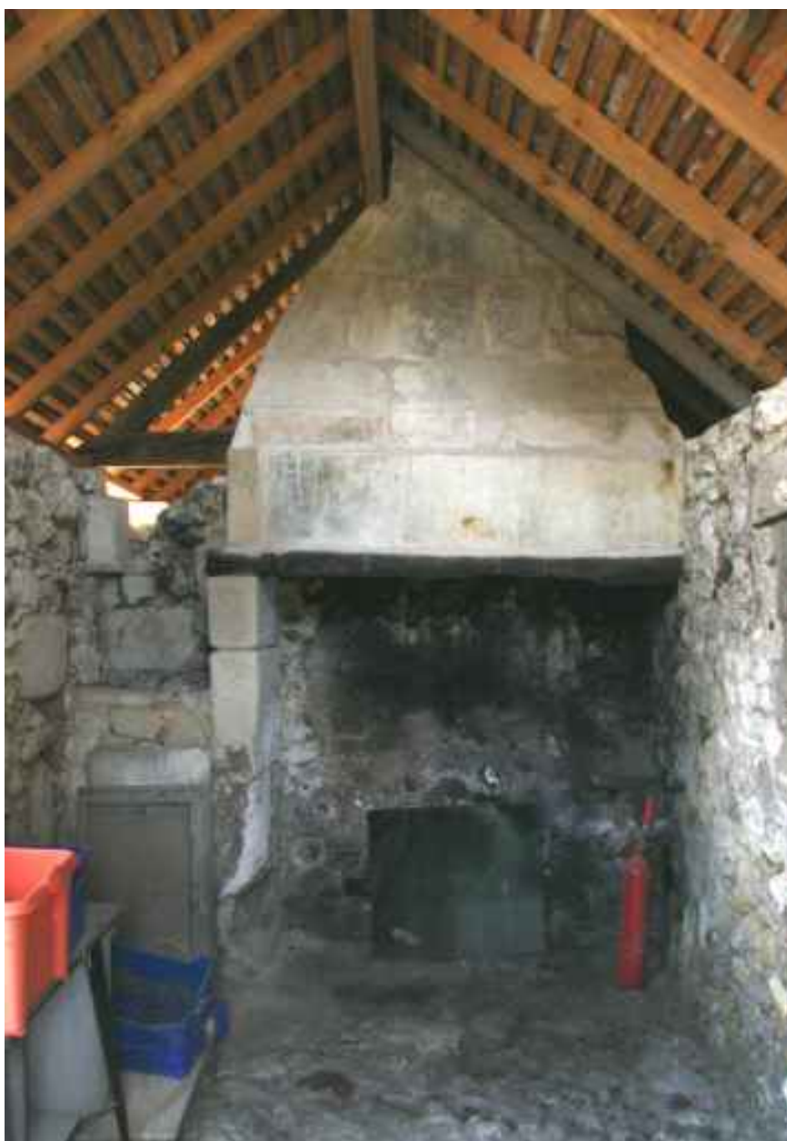
Cheminée aménagée dans les soues à cochons.
