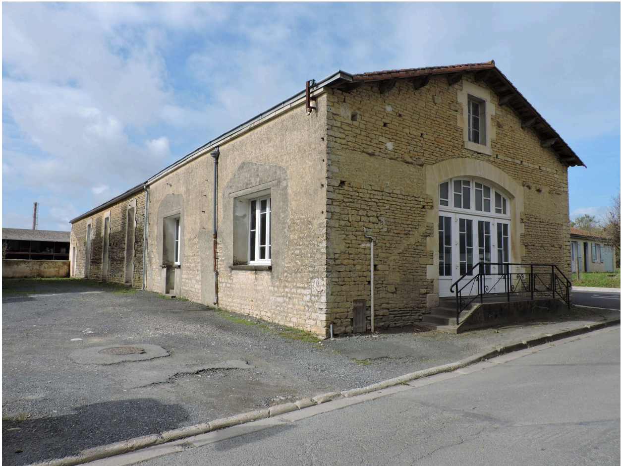
La salle vue depuis le sud-est.
