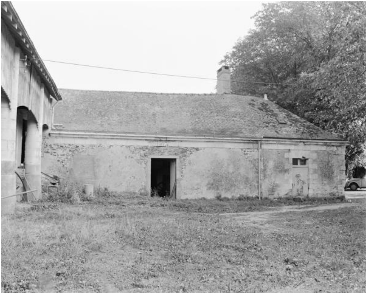
Logement de ferme, façade arrière, 1985.
