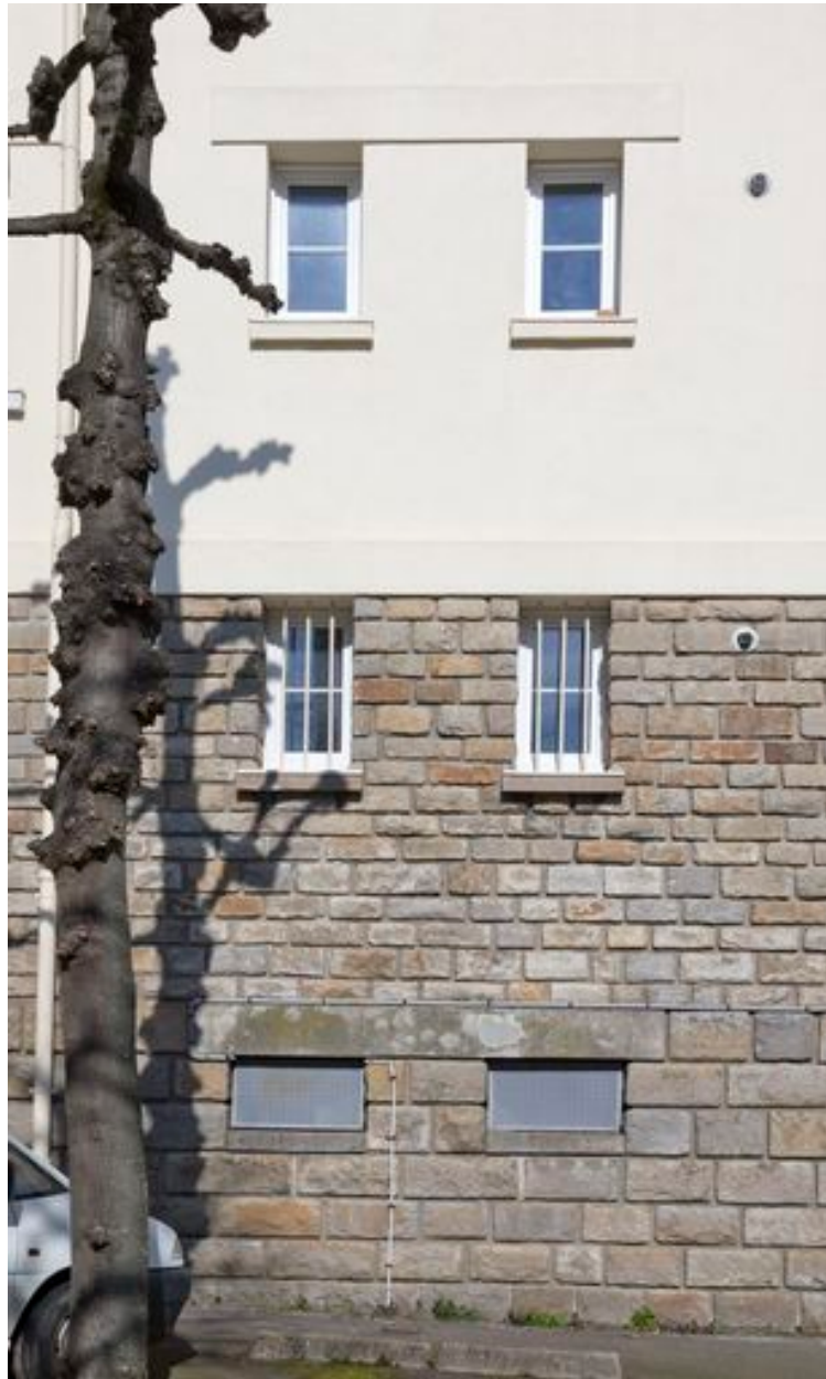
Fenêtres, RDC et 2 premiers étages, Bâtiment A.
