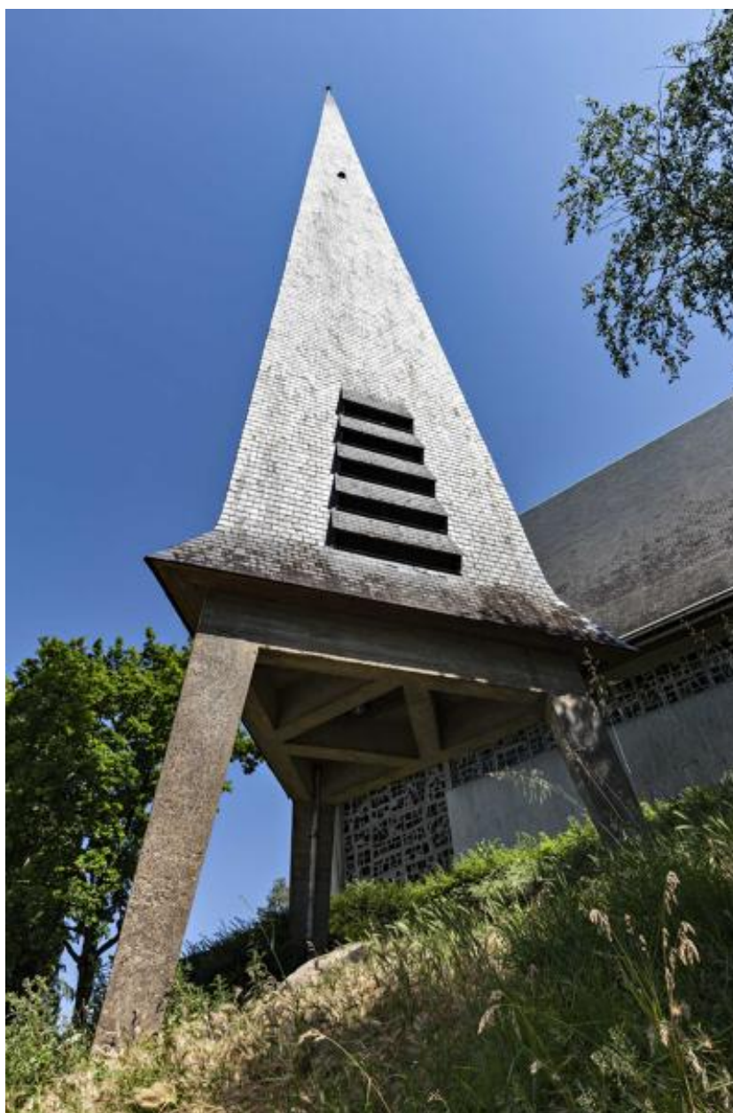
Vue du clocher hors-oeuvre.
