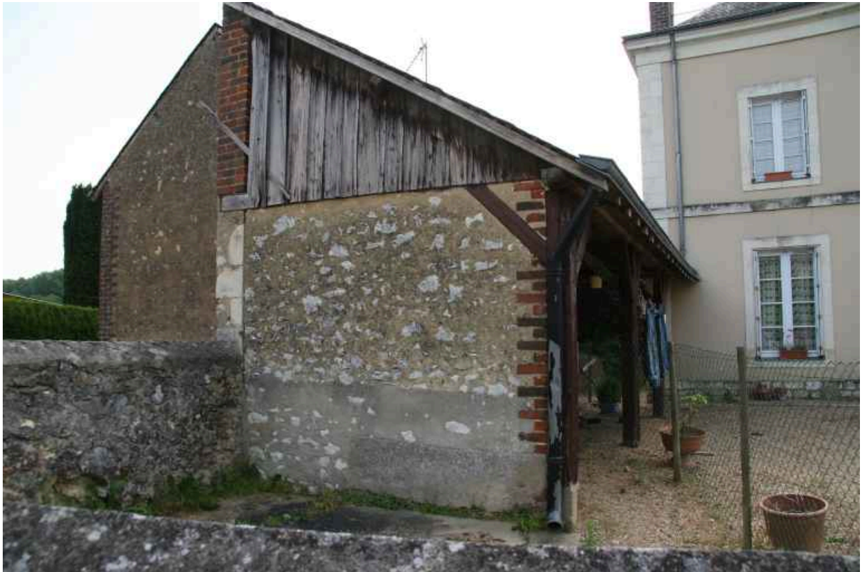
La Maison d'école de garçon : le préau.
