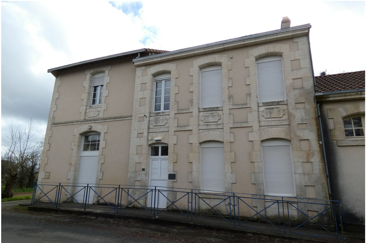
La façade nord du bâtiment de la mairie et de logement d'enseignant.
