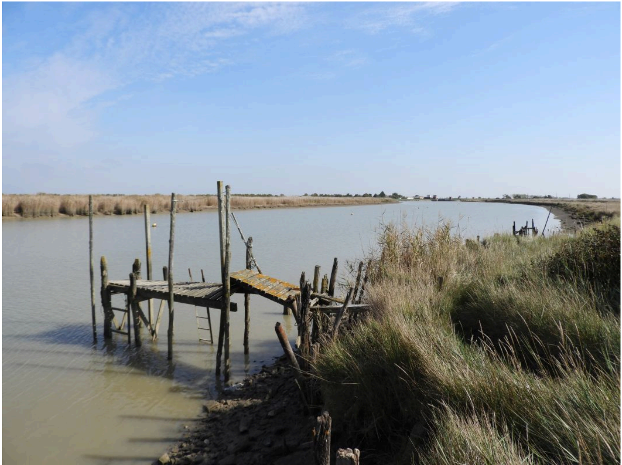
La Sèvre en amont du pont mobile du Brault, vue en direction de l'est.
