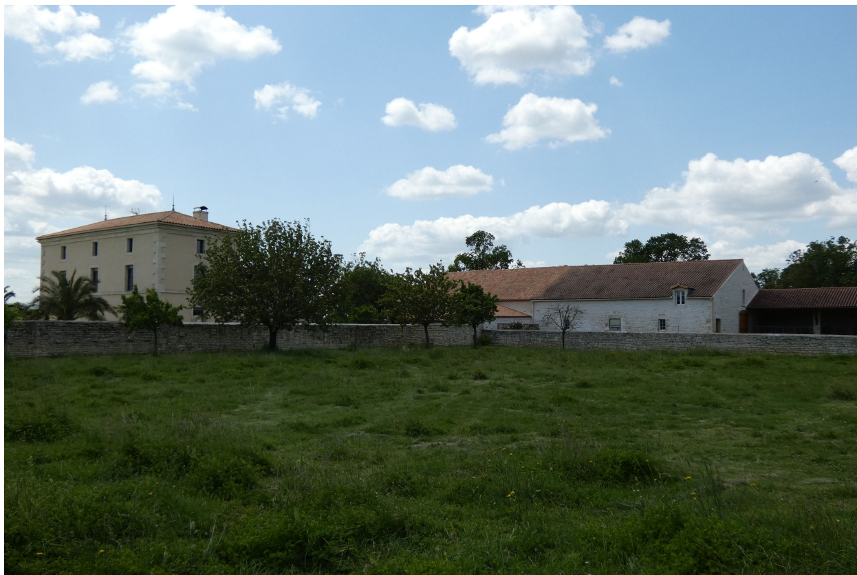
L'ancienne ferme vue depuis le nord-est.
