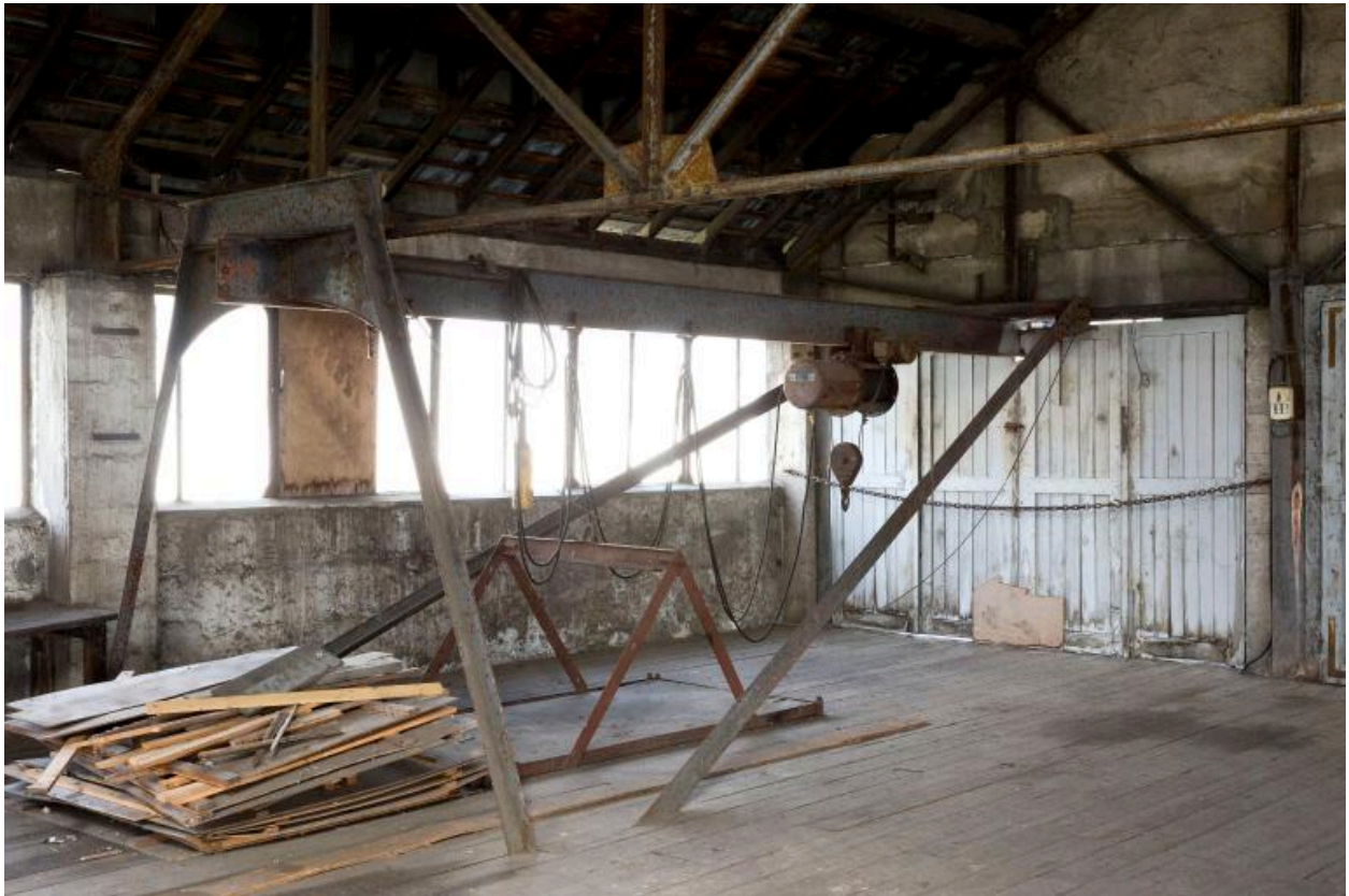
Salle à tracer : 2e étage, système de levage des formes.
