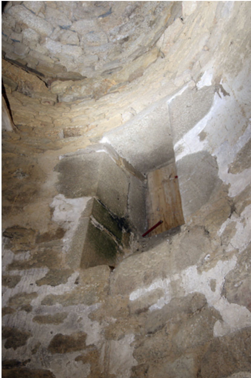
Logis. Tour d'escalier. 3e niveau. Jour d'éclairage.
