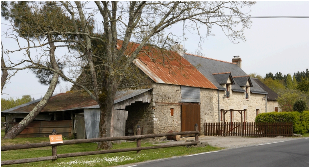
Vue d'ensemble de la rangée.
