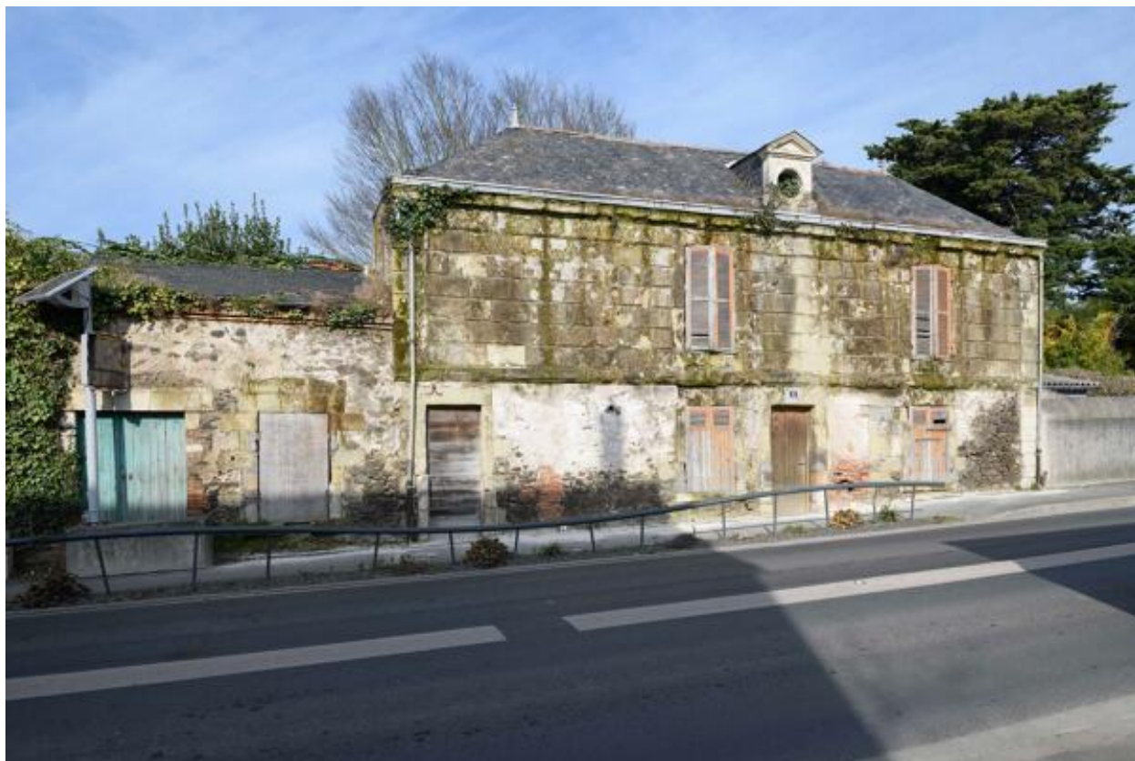
Vue d'ensemble de la maison 6 rue d'Anjou.
