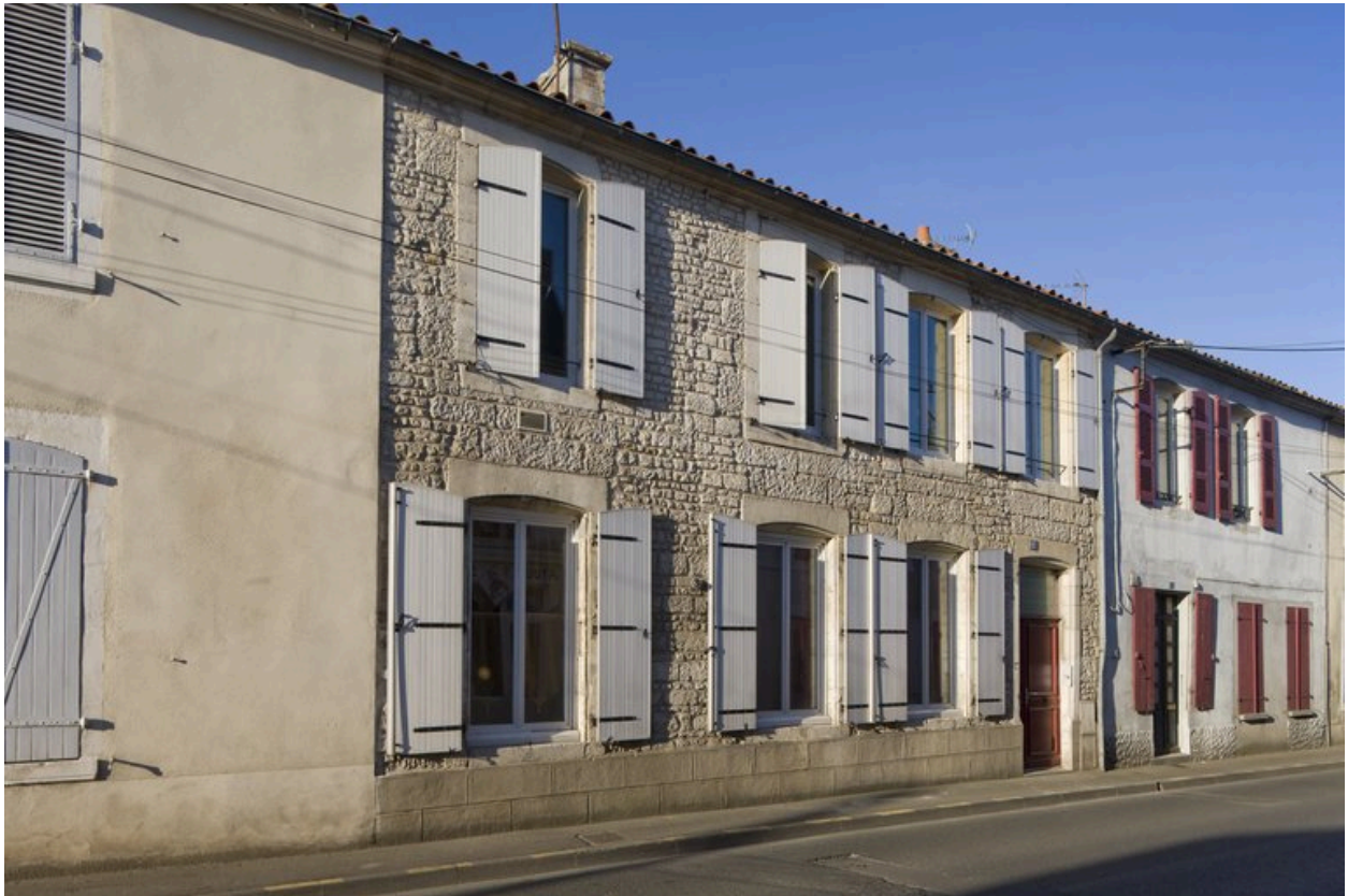
Façade nord, sur rue.
