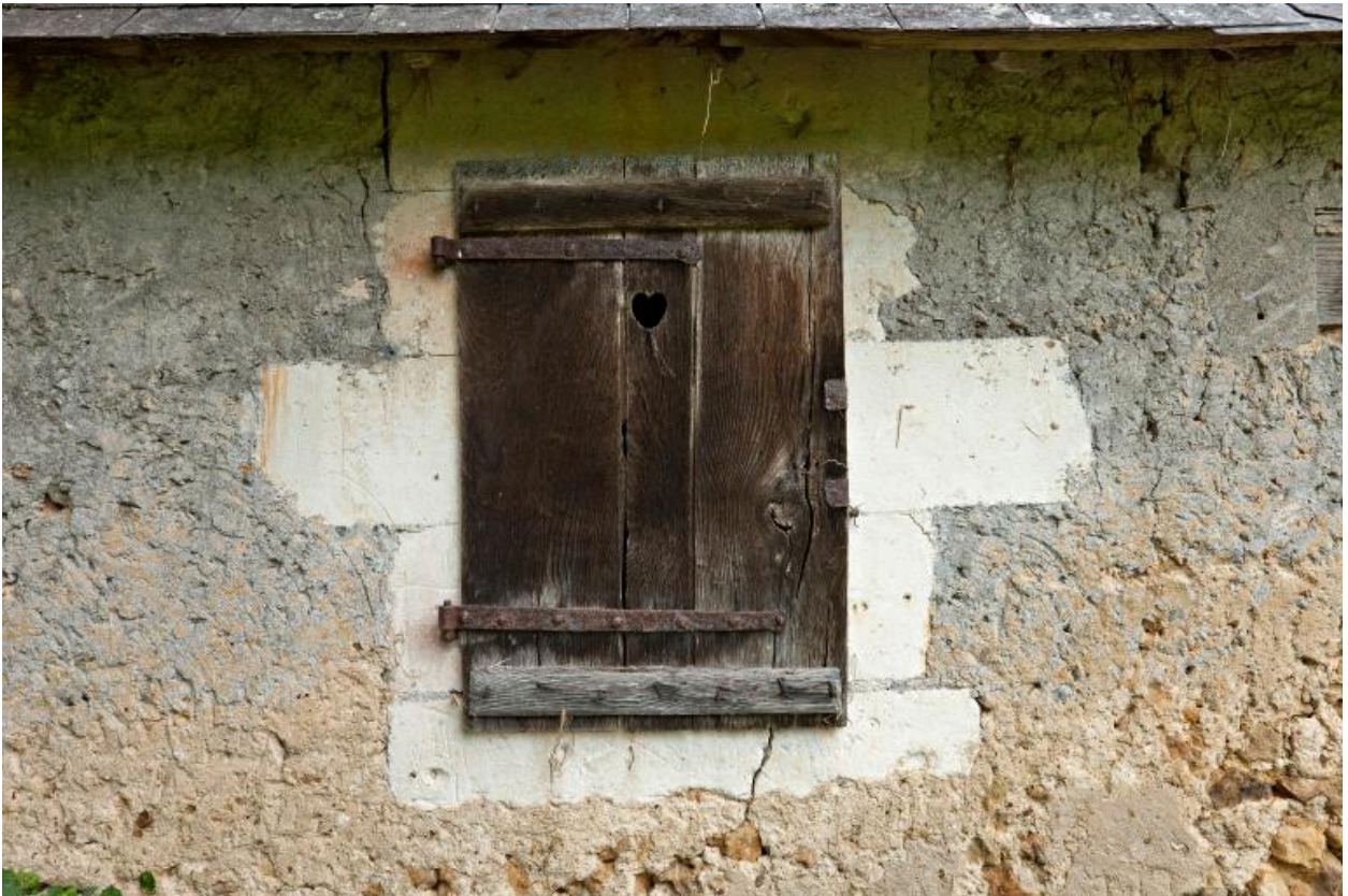
Façade antérieure : baie de la chambre à feu.
