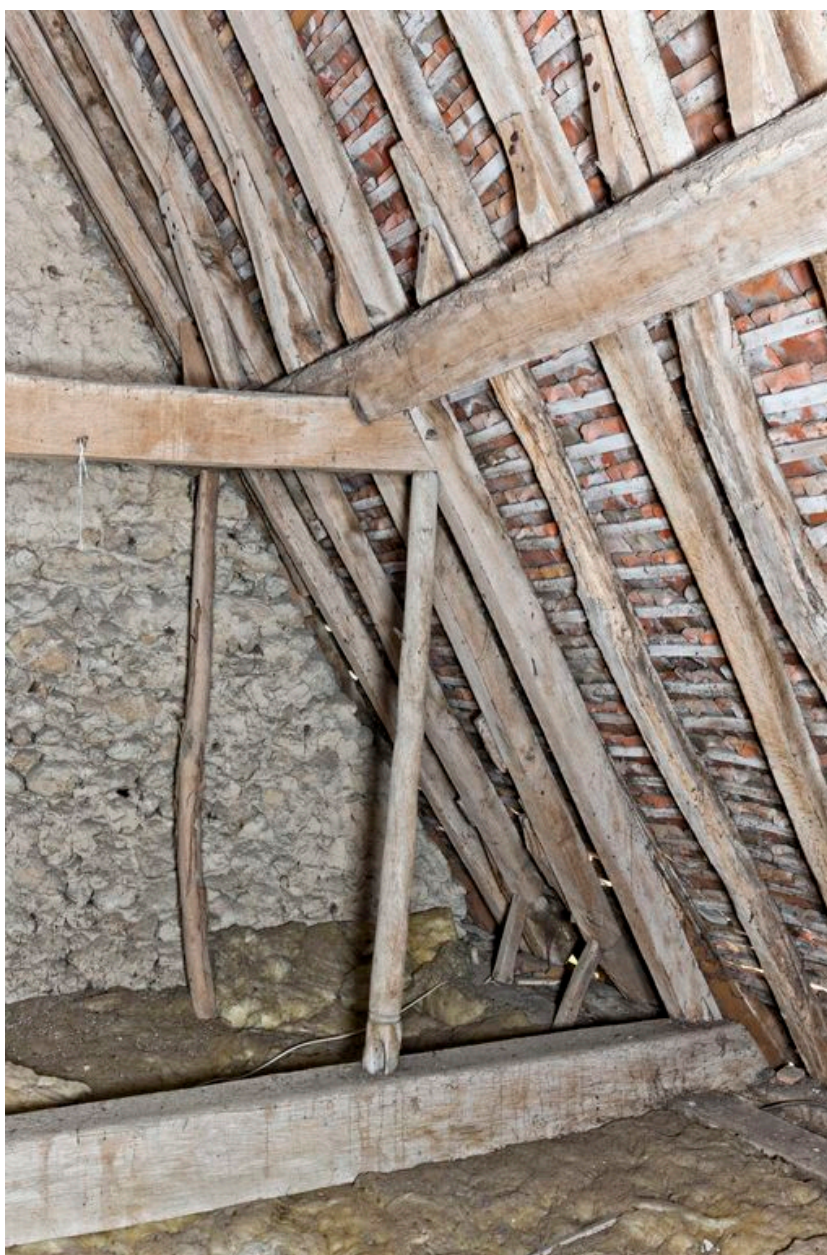
Détail de la charpente.
