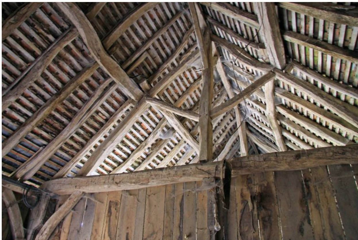
Le hangar : charpente à pannes.
