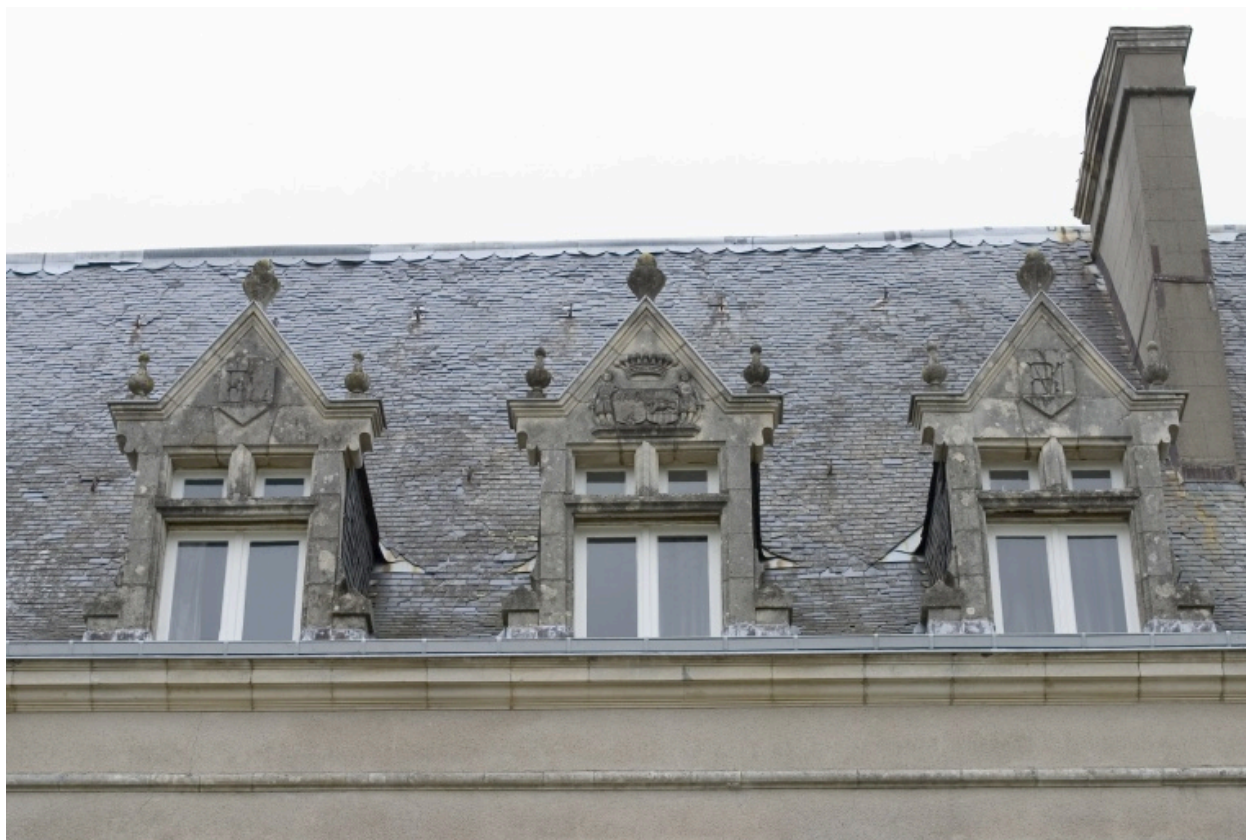
Les trois lucarnes centrales.
