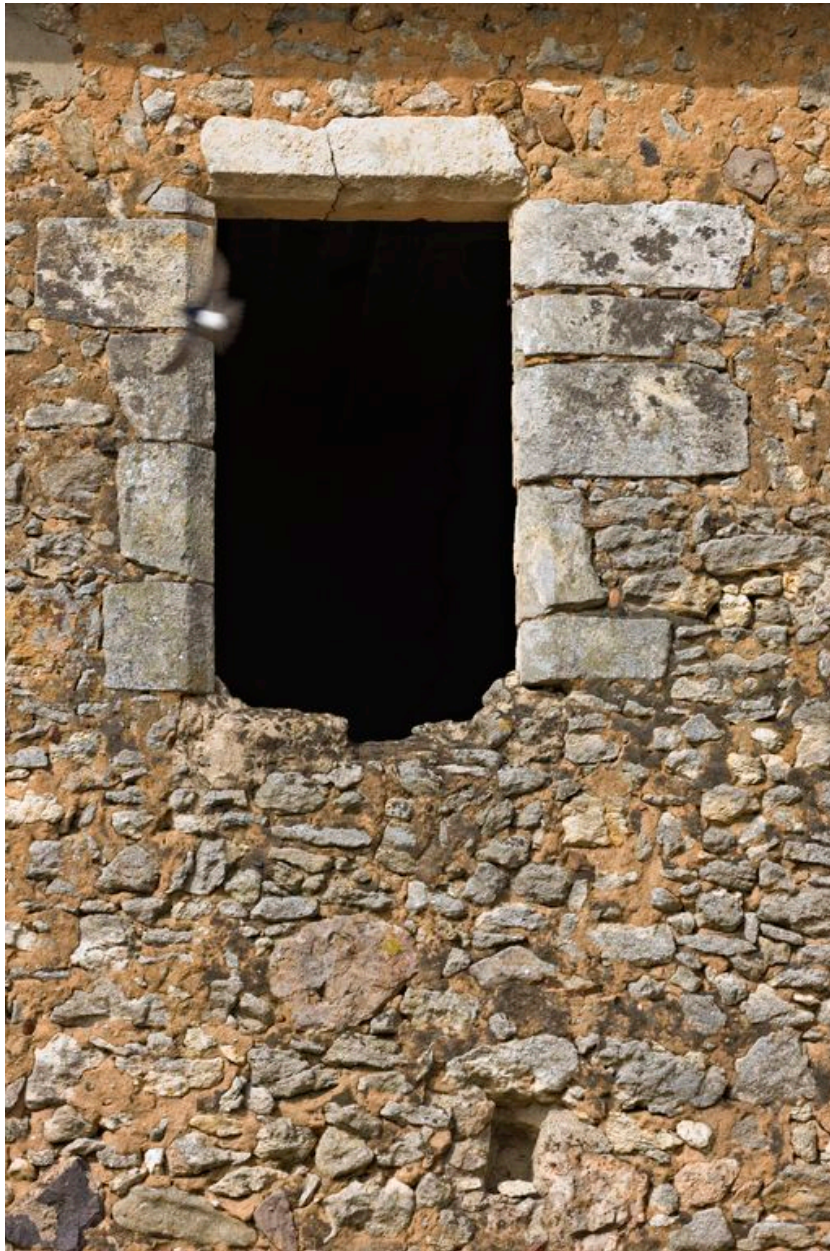
Fenêtre sud de l'étage carré de l'aile en retour du logis.
