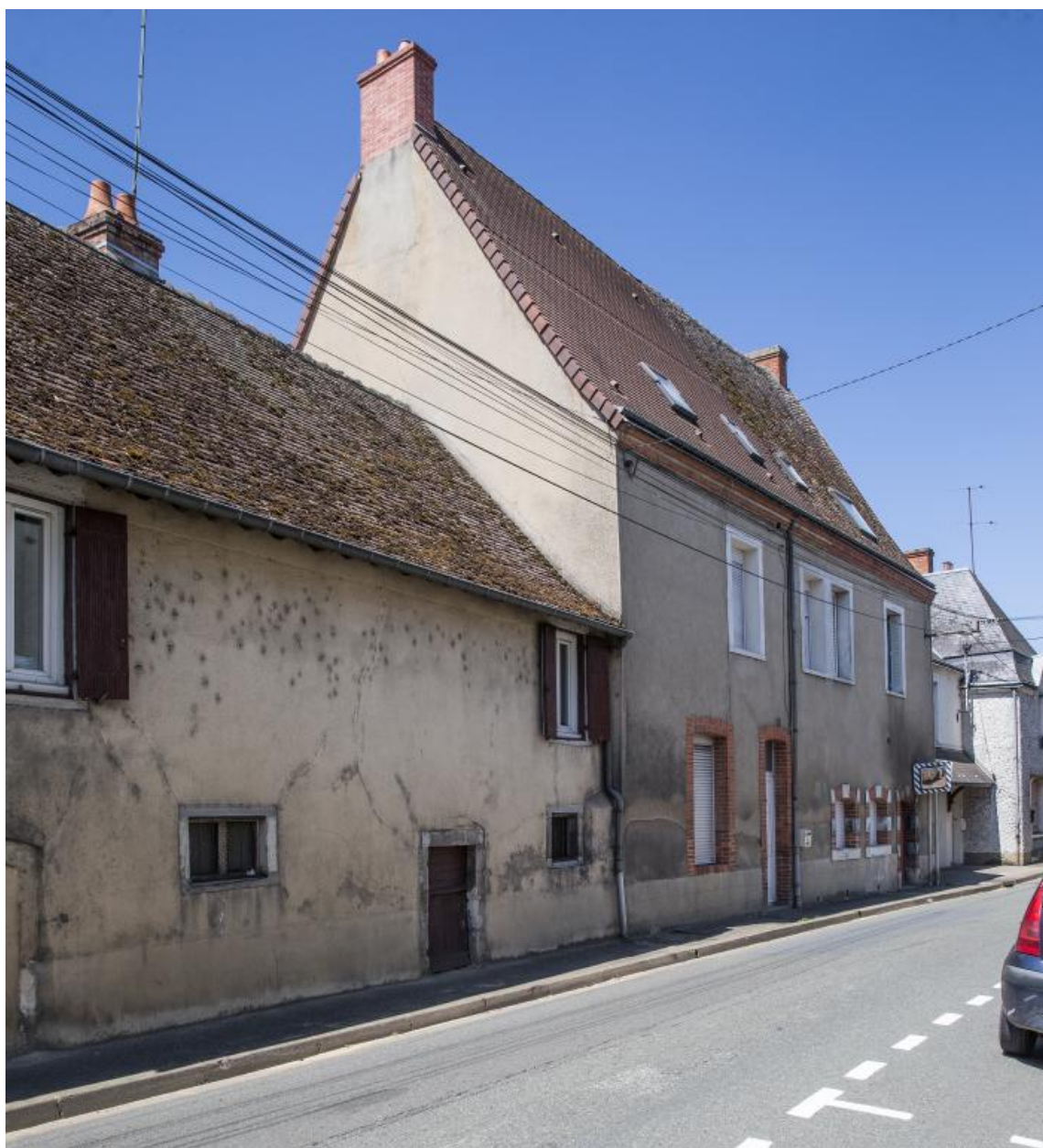
Une maison du XVe ou du XVIe siècle, rue de la Gare.
