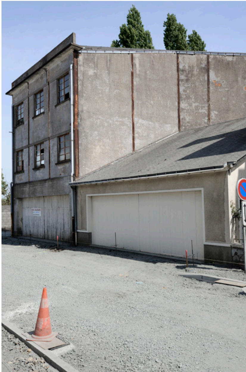
L'usine Repussard-Chupin, vue depuis la rue d'Anjou.
