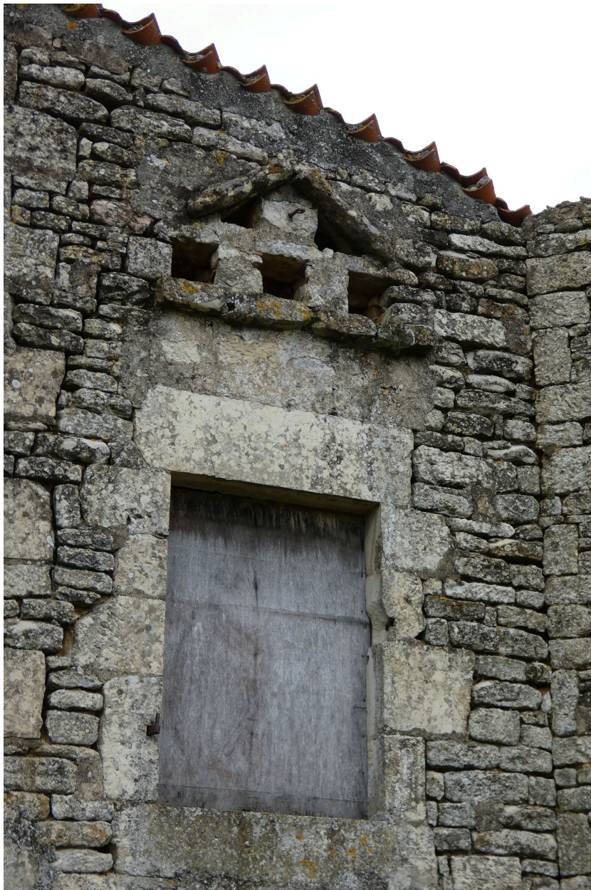
Détail des dépendances au sud de la rue : boulins à pigeons.
