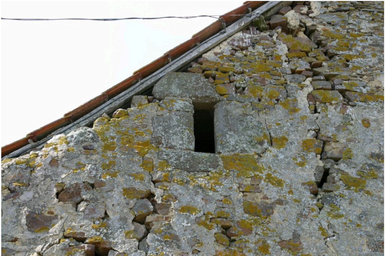
Détail du pignon nord-est du logis-étable.
